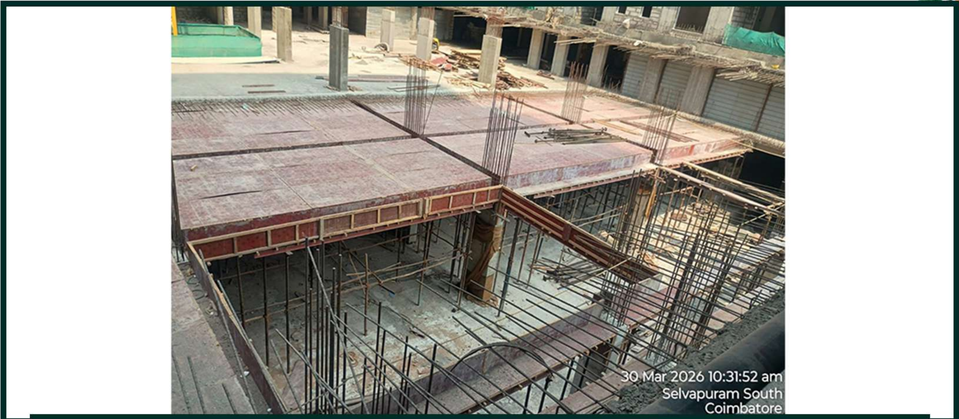
Pour 9A Basement Roof Slab Shuttering Work In Progress
